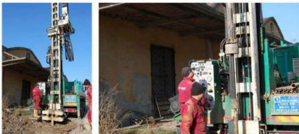
*Fasi dell'esecuzione di una delle prove SPT in foro*
