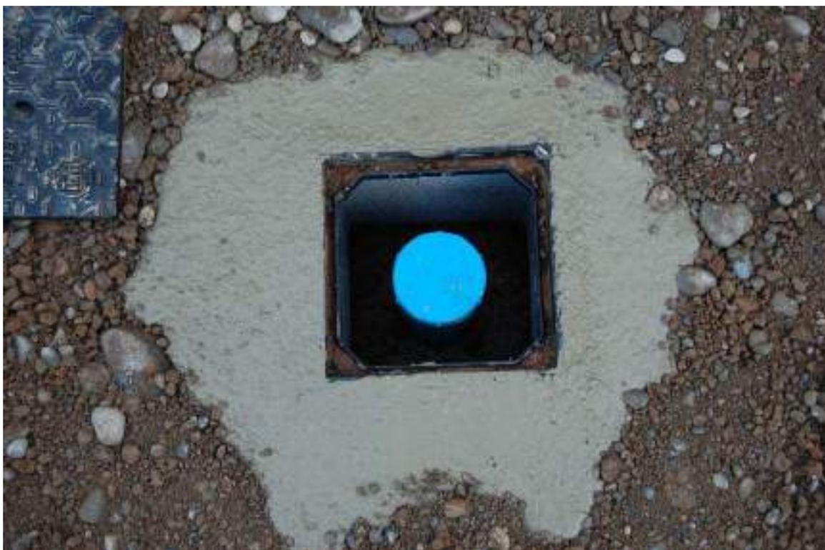
*Il piezometro realizzato nel foro di sondaggio n°3*
