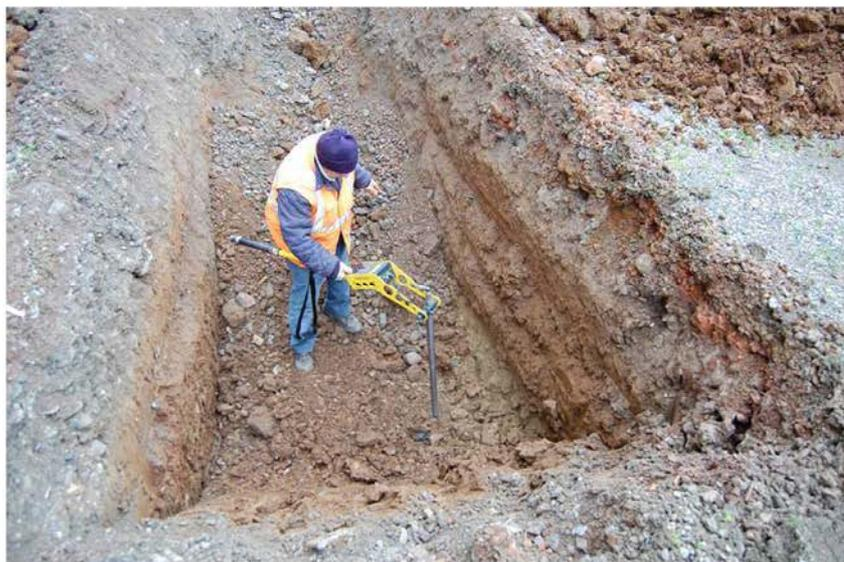
*La trincea eseguita sulla verticale del sondaggio n°3 atta a verificare l'esistenza di ordigni bellici nei primi metri del sottosuolo*
